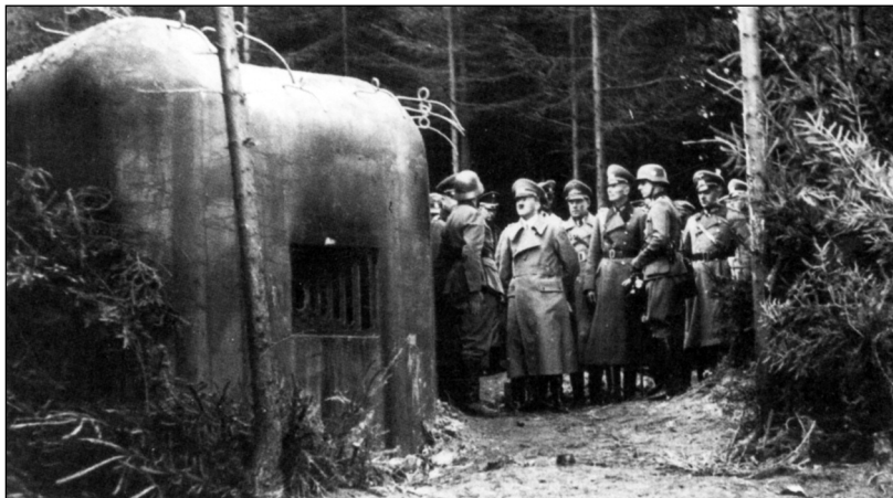
6. 10. 1938 se vůdce seznamuje s „Československou maginotovou linií“. Na snímku u čs. objektu č. 30/N1/-1802. Odsud 7. 10. 1938 následuje návštěva Krnovska a Bruntálska. Cestou je přichystáno bouřlivé uvítání v obci Nové Heřminovy.
