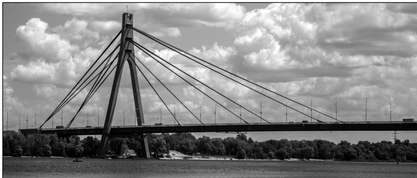
Strategické mosty v Kyjevě přes řeku Dněpr
