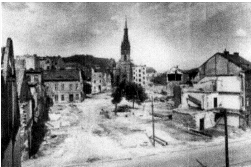
Bombardováním vychýlená věž ústeckého gotického kostela
