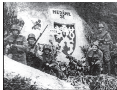
Palebné postavení čsl. armády z června 1938 u vchodu do podzemní chodby v lokalitě „V jámě“ Foto archiv
